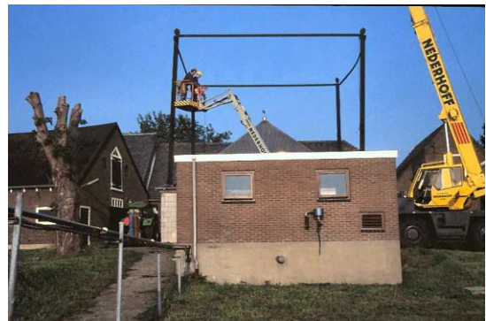
Het demonteren van de hooibergconstructie.
